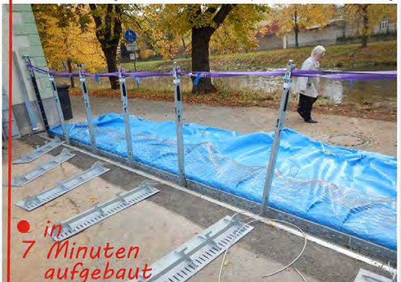
Die AquaWand wird für den Einsatz vorbereitet.
