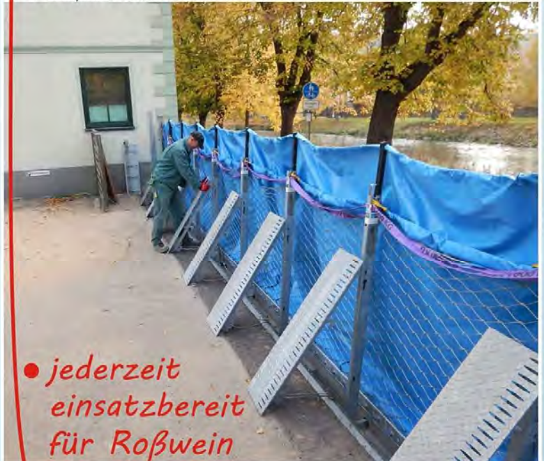
Der Aufbau ist abgeschlossen, die AquaWand ist einsatzbereit.
