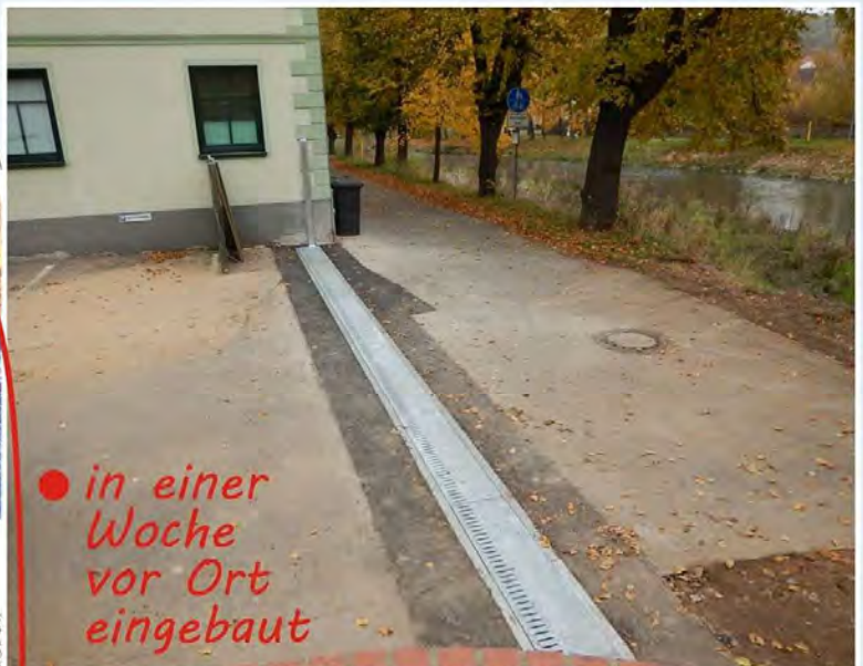
Die AquaWand im eingebautem Zustand. Optisch sieht man eine Linienentwässerung. Tatsächlich verbergen sich alle Elemente der AquaWand unter der Abdeckung.
